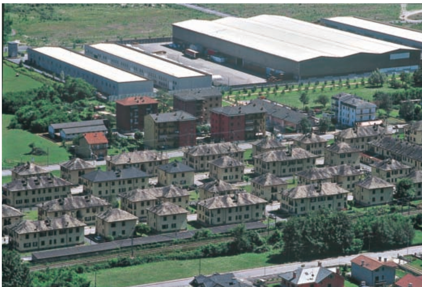
Villadossola, recupero ambientale del Villaggio Sisma
